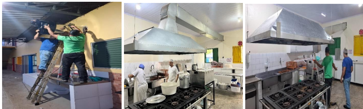
Aquisição e instalação de coifa industrial
