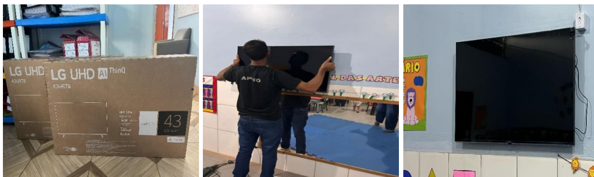
Aquisição e instalação de televisores nas salas de aula
