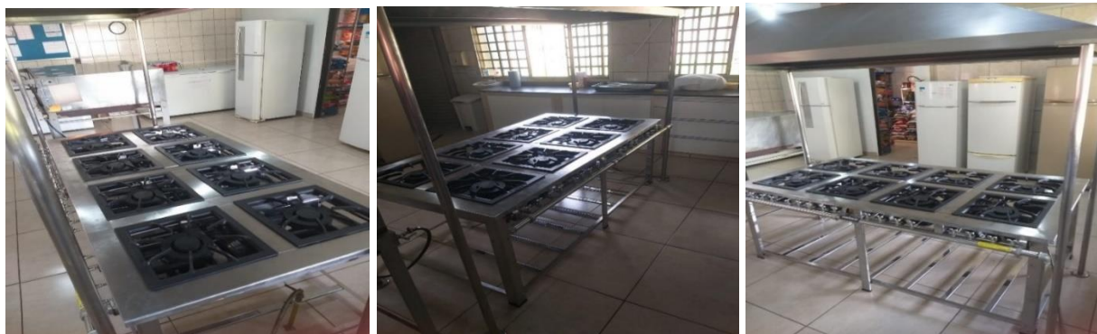
Instalação de novo fogão Industrial
